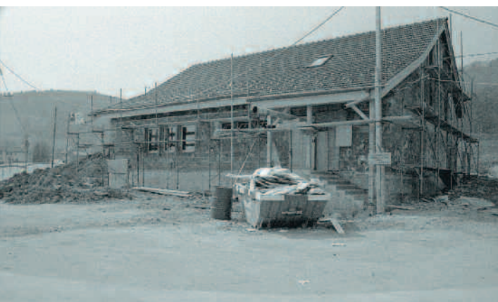
Das zweite, jetzige Schützenhaus im Rohbau.
